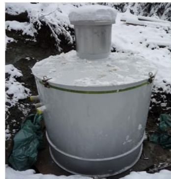
Brunnenstube, bestehend aus Polypropylen und Chromstahl
