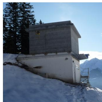
Zentralgebäude Maschinengruppe, aufgebaut auf der Schieberkammer des Reservoirs
