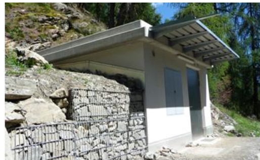
Annexgebäude neben Reservoir
