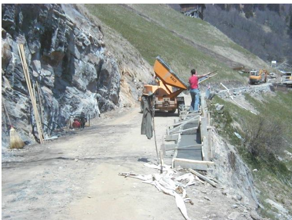
Während den Bauarbeiten
